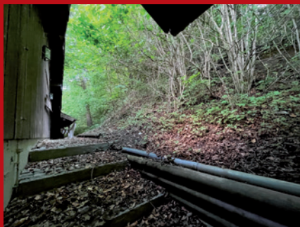
Die kühle Rückseite des Theaterbaus
